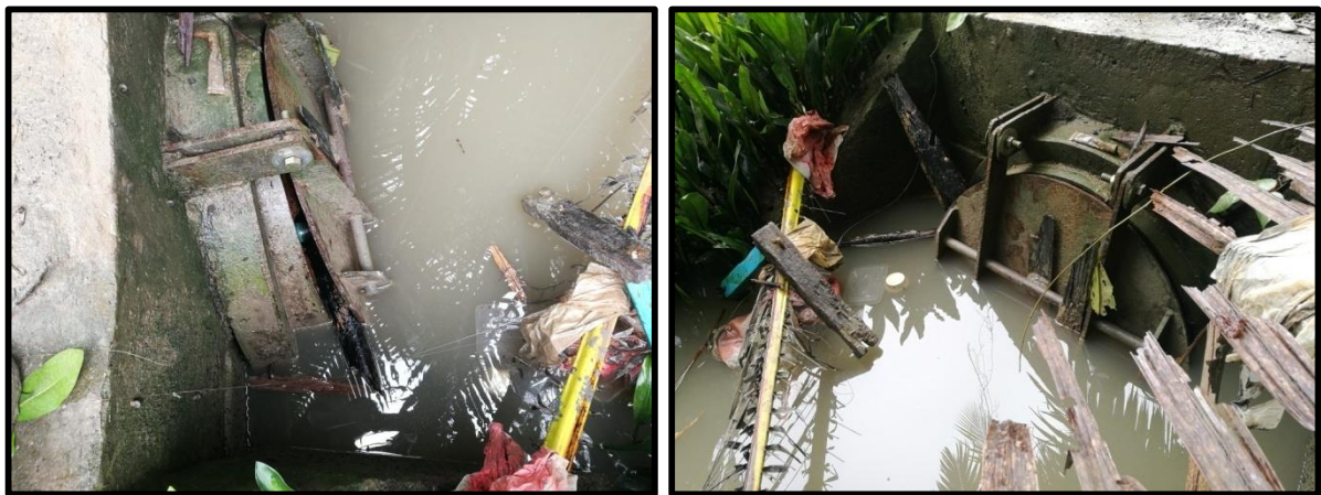
Rajah 9: Gambaran halangan permukaan pintu air disebabkan longgokansampah
